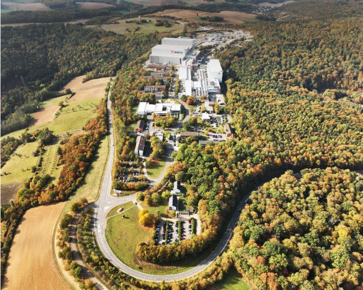
Bild 1: Luftaufnahme Industriepark Würth.jpg
